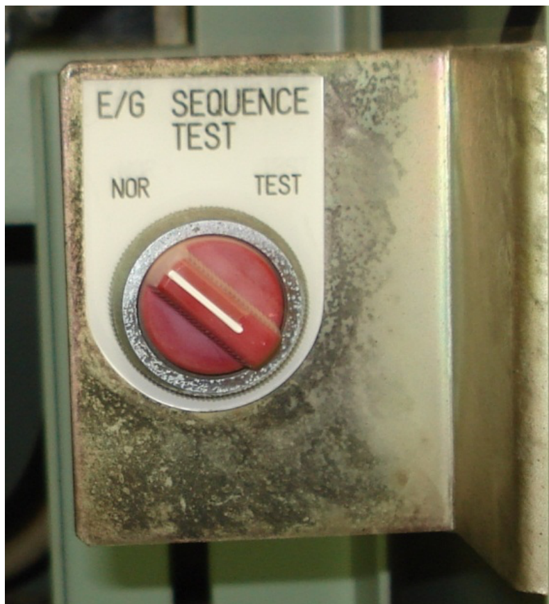
Рис. 5. Перемикач перевірки автозапуску АДГ (E/G SEQUENCE TEST – NOR/TEST)
