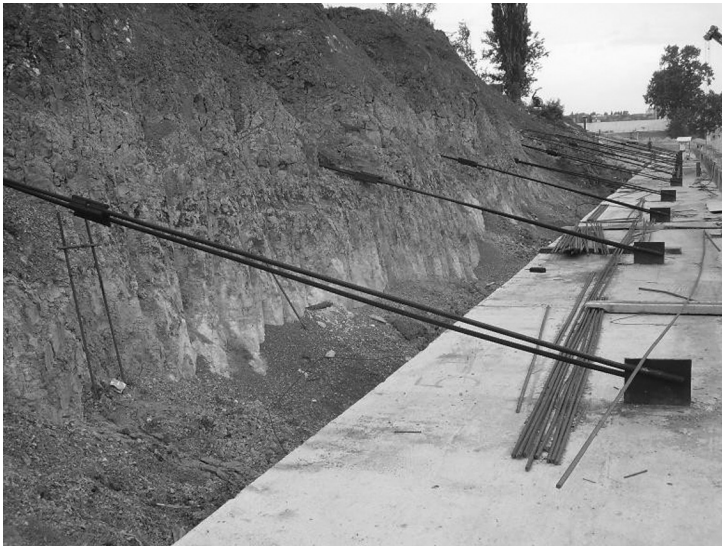
Рис. 2. Влаштування анкерних тяжів на підпірній стіні
